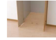
出し入れがスムーズな三方枠。下部のドアストッパーは薄型タイプ。
